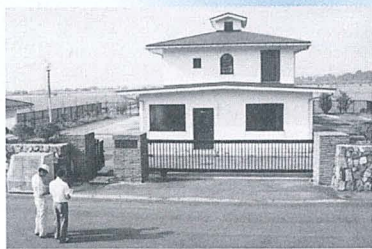
◀宇奈月町下立地区 排水処理施設
