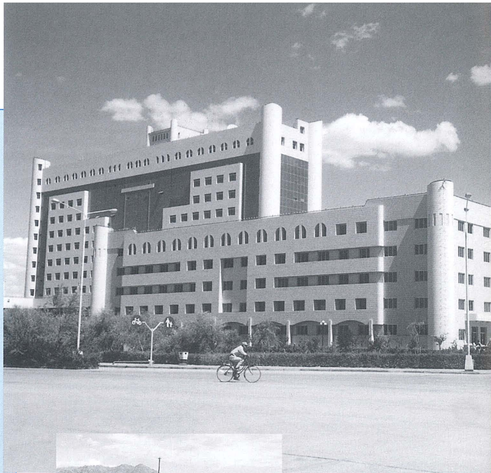
▲哈密市郊外に建設された石油研究所。その巨大で近代的な姿に圧倒される
