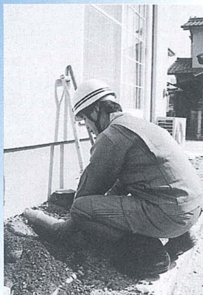
宅内排水設備工事
