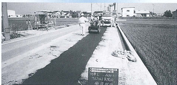
下水道の舗装復旧工事（吉原地内）
