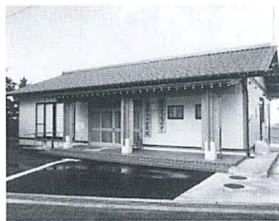
▲完成した吉原3区コミュニティセンター
