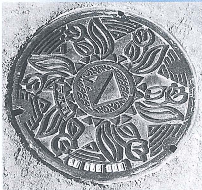
小摺戸地区の一宿公民館付近の道路に設置されたマンホールのふた
