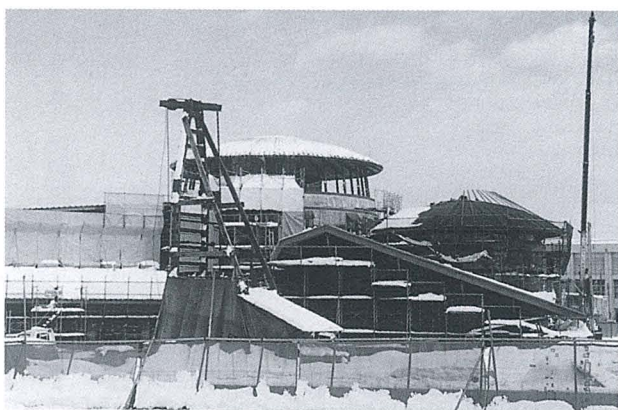
総合体育館西側で建設が進む「健康交流プラザ」－3月10日撮影－
