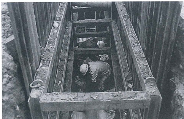
早期の供用開始を目指し、町内各地で進む下水道整備
