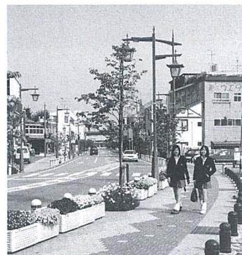
駅から国道8号につながる中央通り線
