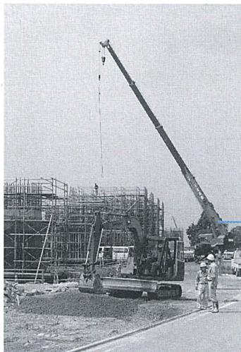
小摺戸地区区内進む、北陸新幹線の高架橋土台固め工事
