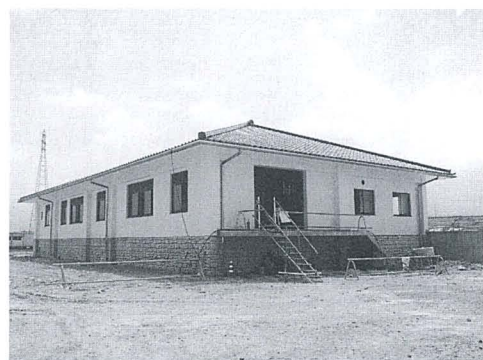
完成間近の小摺戸浄化センター
