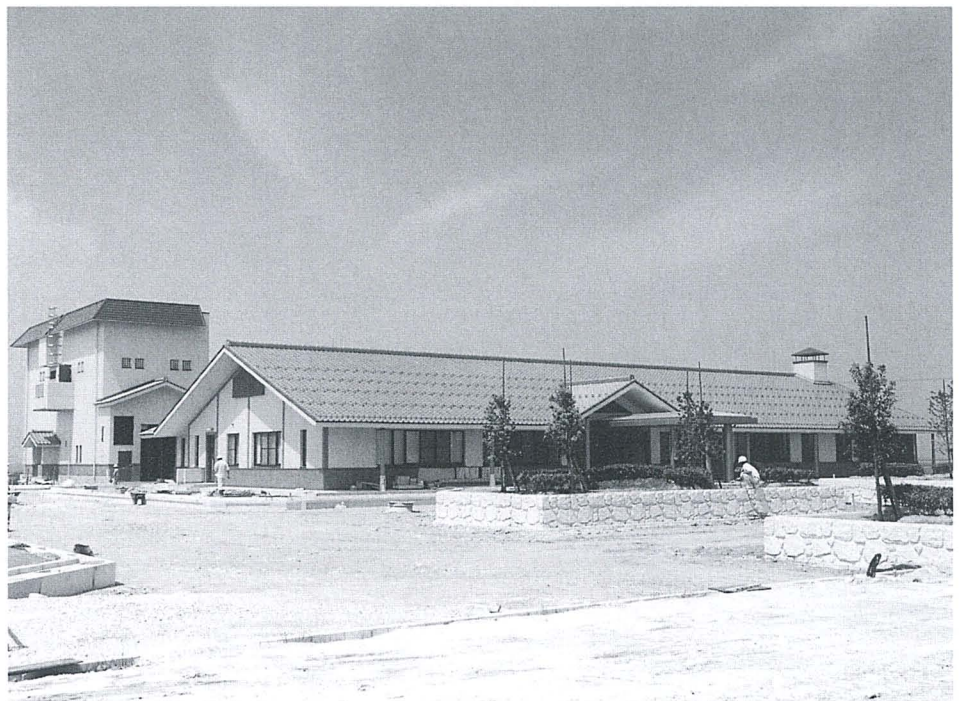
8月末に一部完成、9月1日使用開始となる入善浄化センター（東五十里地区）
