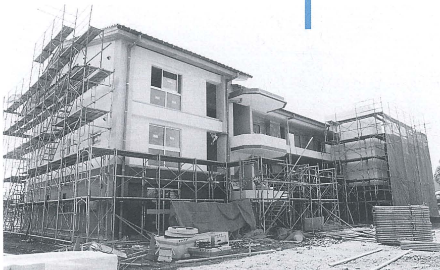
完成間近の東町町営住宅A棟。公営9戸、特公賃6戸を整備
