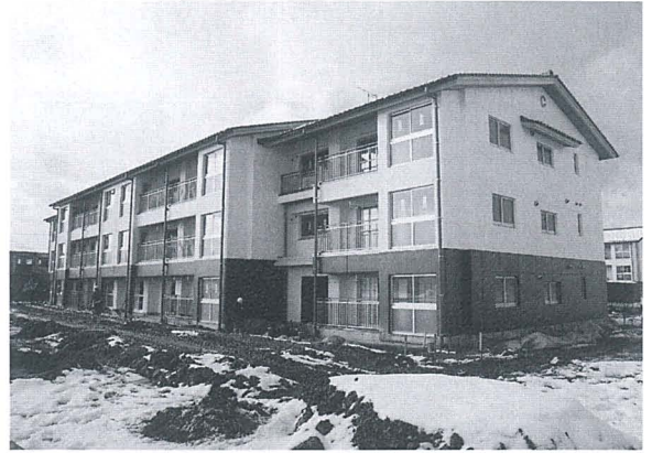
建設中の町営東町住宅C棟。公営住宅19戸を整備
