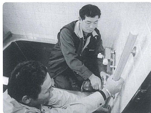
浴室に手すりを設置する組員
