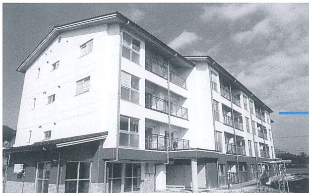
建設中の東町町営住宅B棟。公営住宅23戸を整備
