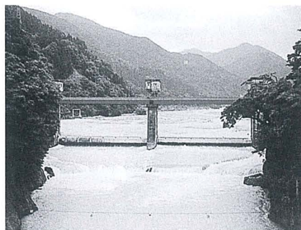
愛本堰堤の工事のため、黒東合口用水が断水
