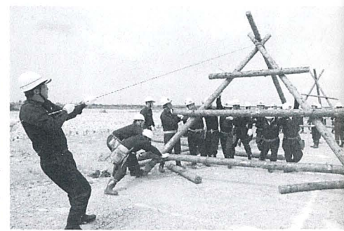
▲松丸太を組み合わせせ川に入れる川倉工
