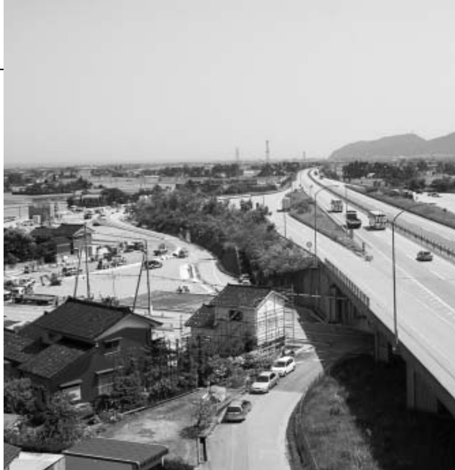
▲リニューアルオープンに向け、着々と工事が進む入善スマートIC
