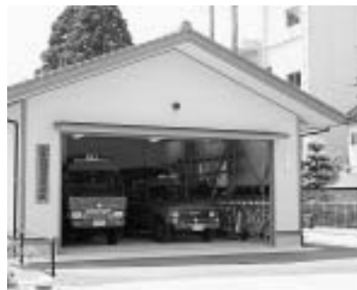
完成した入善分団屯所
