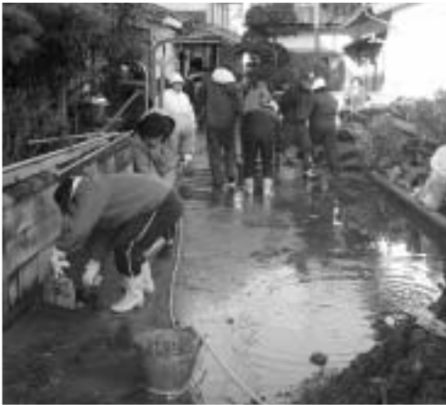
▲狭い路地のため、土砂の撤去作業は手作業で。
