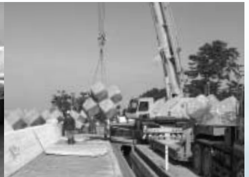
▲護岸堤の開口部に設置される消波ブロック。本格的な対策はこれから。
