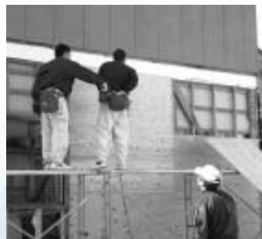
▲災害から3週間が経過し、作業所を修繕する住民ら。
