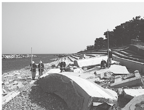
▲護岸施設の復旧に向け、測量作業が進められています。
