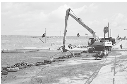
▲漁港内の浚渫工事の様子。
