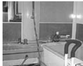
快適空間お風呂・ユニットバス施工。
