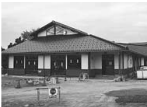
▲建設が進む舟見・野中統合保育所
