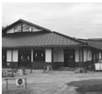
▲建設が進むひばり野保育所
