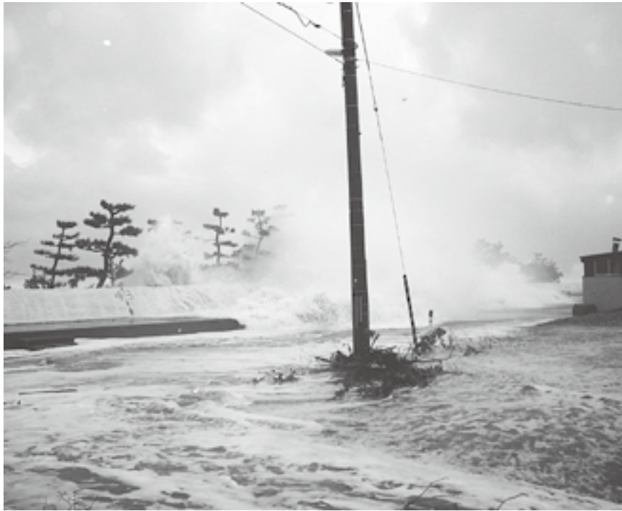
▲護岸堤防を乗り越えた高波が濁流となって集落に流れ込みました
