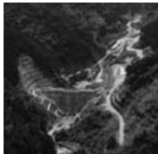
コンクリート打ち込み工事が完了間近の舟川ダム
