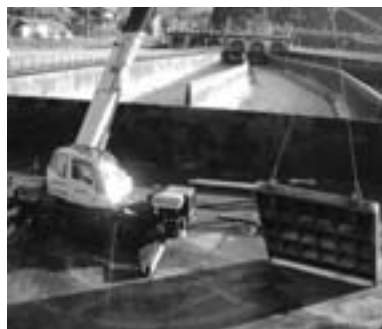
改修作業が進む沈砂池(昨年11月)
