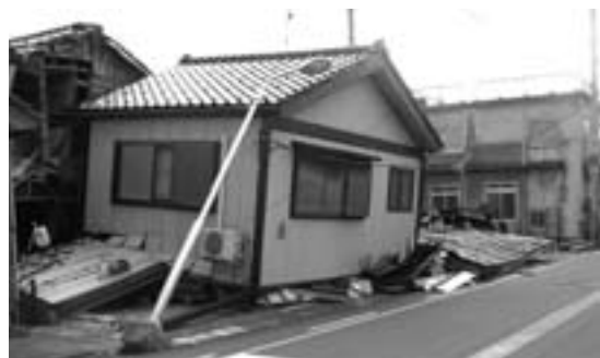
1階が崩れ落ちた家 —消防科学総合センター提供—
