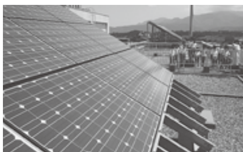
校舎屋上の太陽光パネルを見学する黒東小児童
