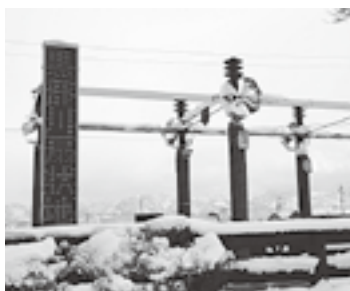
ダイロ発電で「黒部川扇状地」の文字が点灯する電飾掲示板
