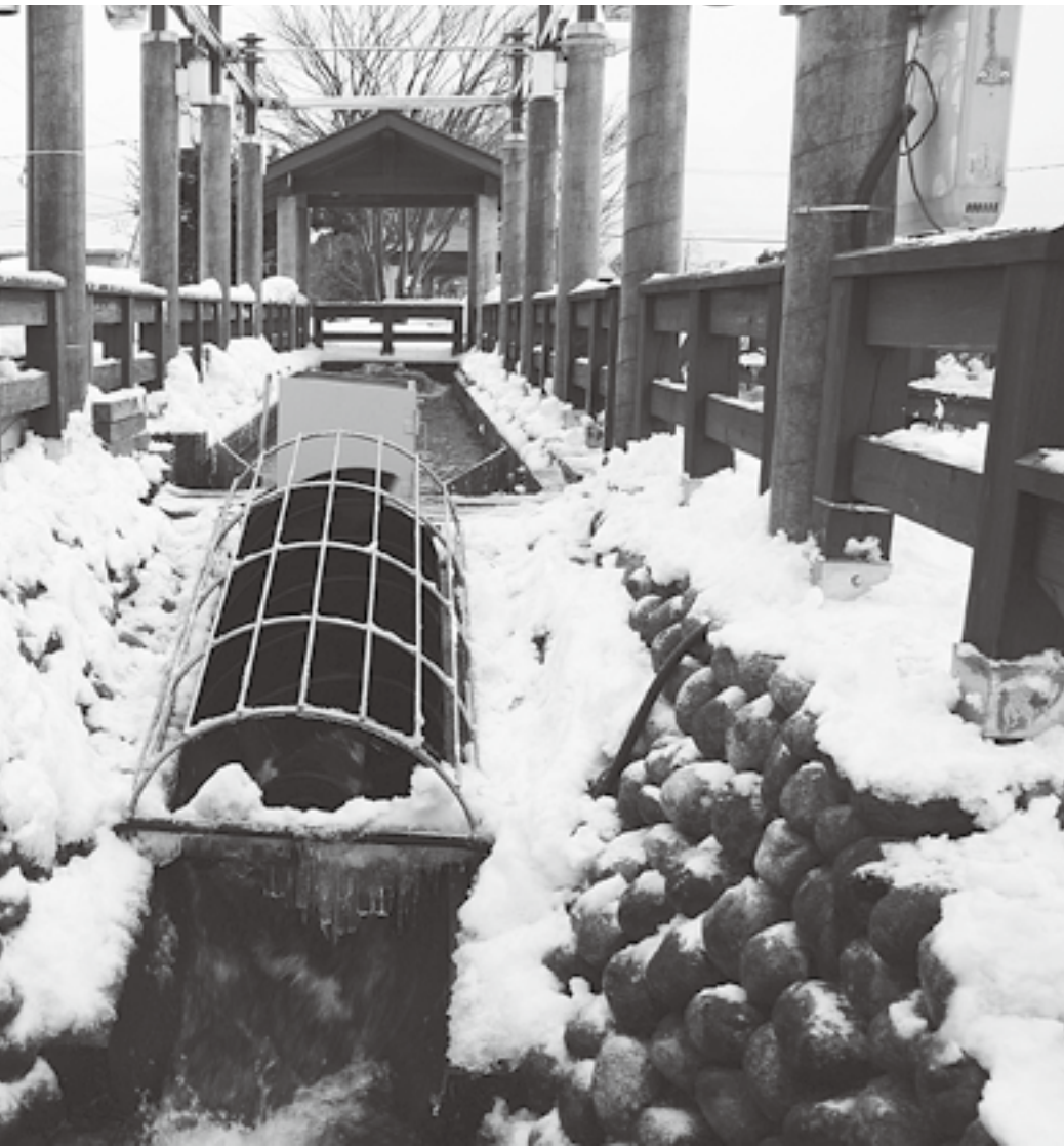
ダイロを使って発電実験する「入善町『水の小径』小水力発電所」
