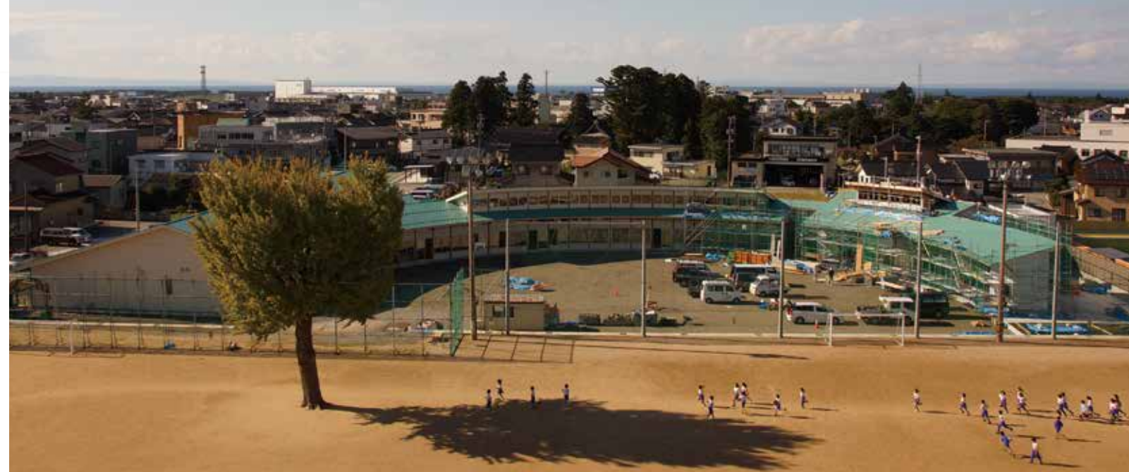
入善小学校北側では入善統合保育所(仮称)の建設が進んでいます。建物は半円型で、園庭で児童が楽しく遊べる設計です
