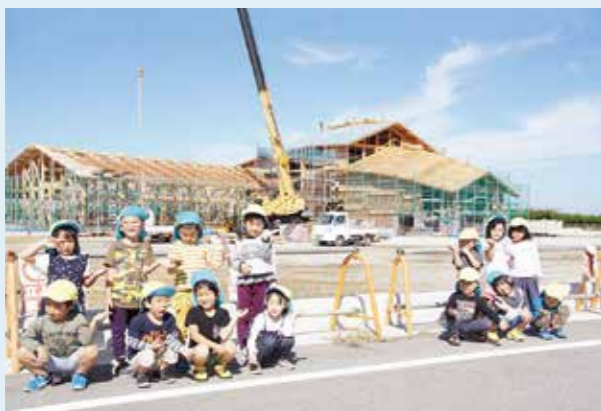
▲飯野統合保育所(仮称)の建設に着手
