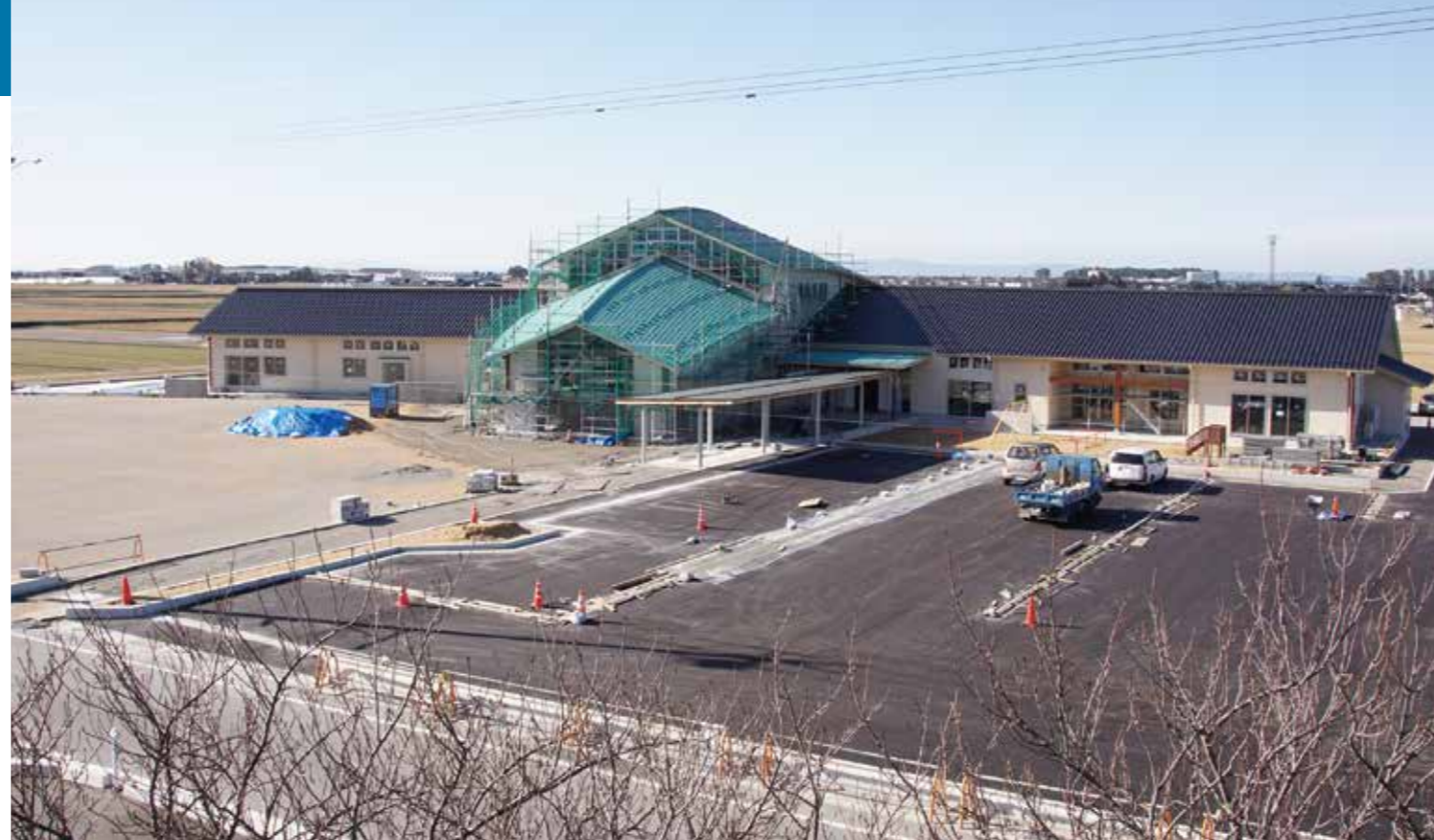
▲今春の開所に向けて工事が進む飯野統合保育所(仮称)
