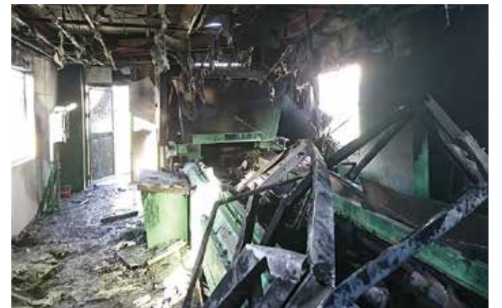
▲リチウムイオン電池の発火が原因で、リサイクル工場の建屋・設備が焼けてしまった事例 出典: (公財) 日本容器包装リサイクル協会
