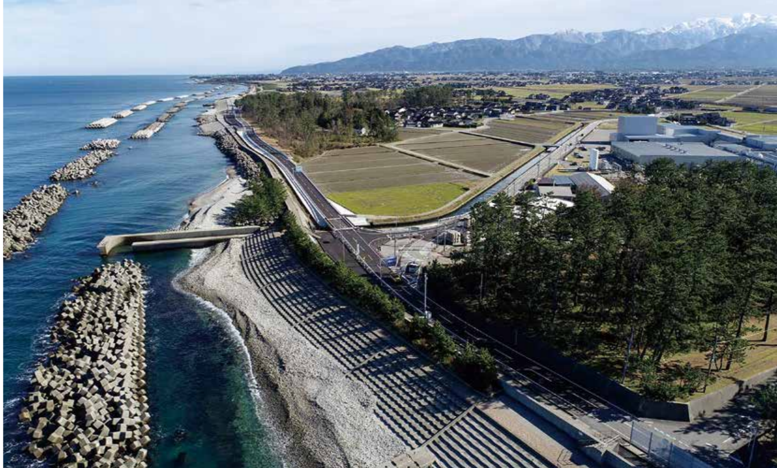
▲海洋深層水パーク周辺(報徳地区)の上空から園家山キャンプ場(園家地区)まで延びる道路
