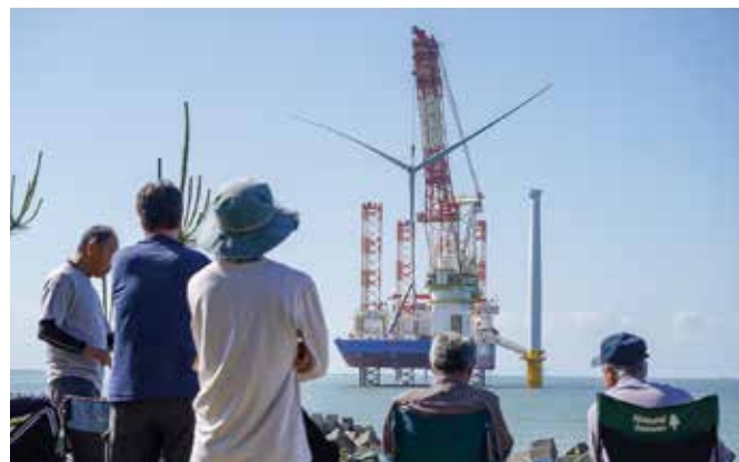
▲4～6月の海上工事には、町内外から見物客が詰めかけた
