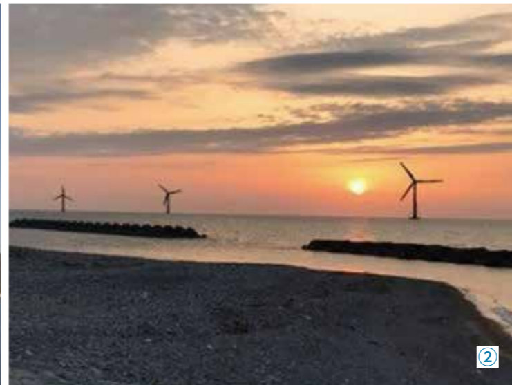
①ワンチームでの連携を誓う(左から)新田八朗知事、 ②風車の完成イメージ図③海上工事の要となるSEP船「BLUE WIND」がジャッキアップした様子④観光客の休憩スペースにもなる横山地内の管理棟
