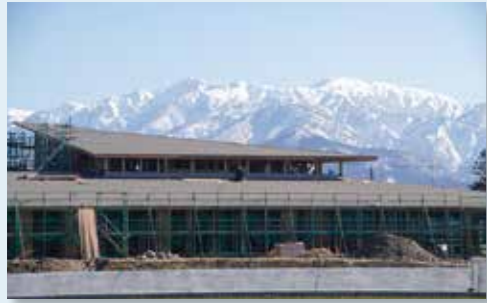
▲建設が着々と進行中
