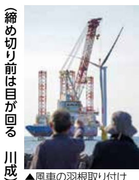
▲風車の羽根取り付け
