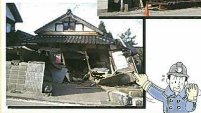
能登半島地震(震度6強)により倒壊・全壊した家屋 (気象庁HPより)
