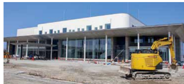
▲建設が進む役場新庁舎
