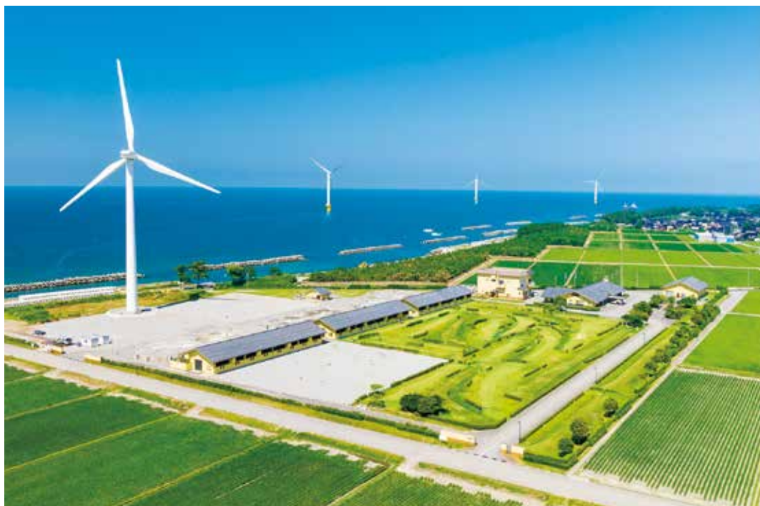
▲町の下水処理を一手に担う「入善浄化センター」。設備の運転には、センター敷地内の陸上風力発電施設から得た電気を活用
