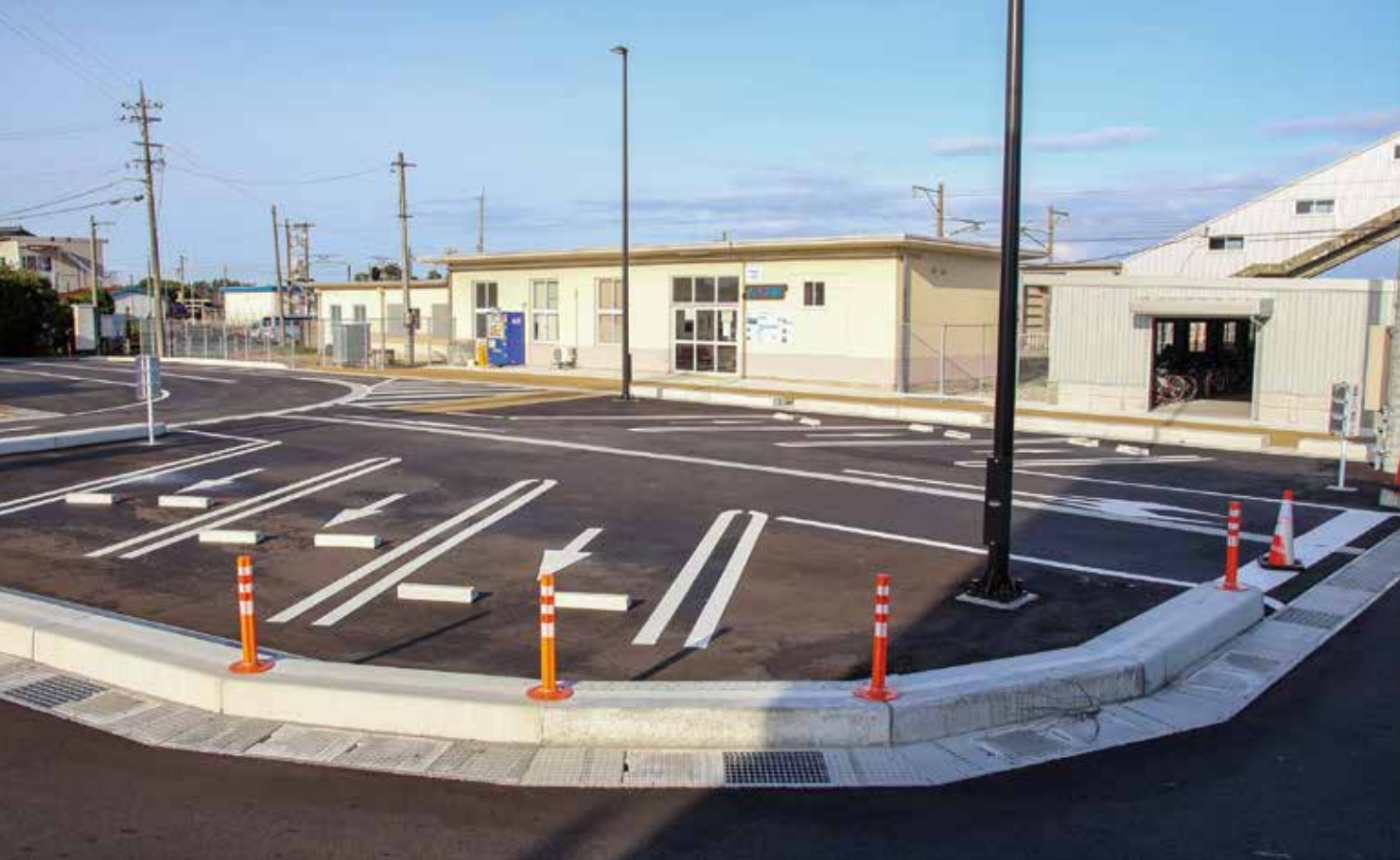
▲完成した西入善駅前広場
