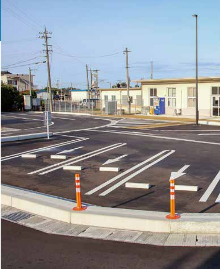
▲完成した西入善駅前広場
