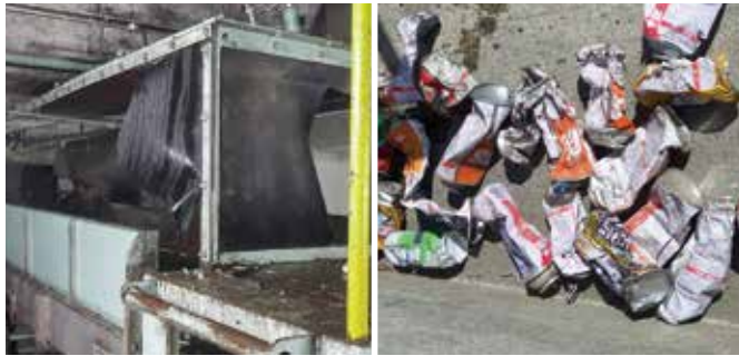
▲爆発でごみ処理設備が破損
