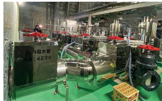
▲ポンプ4基が入る地上1階・地下2階の取水ピット
