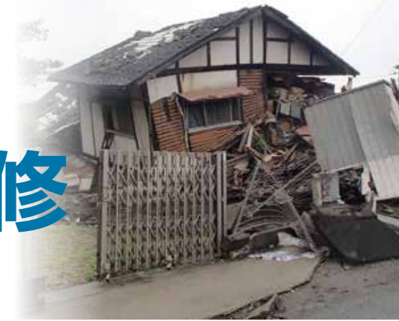
▲熊本地震で倒壊した住宅 (富山県土木部建築住宅課 提供)
