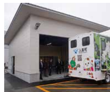
▲トレーラーとともに整備された防災車庫
