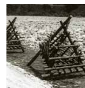
▲丸太を組み上げた「川倉」で流れを緩やかに(川倉工)
