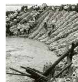
▲竹で編んだ籠に石を詰めて堤防を補強(竹蛇籠工)
