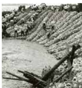
▲竹で編んだ籠に石を詰め堤防を補強(竹蛇籠工)
